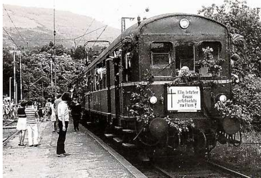
Der letzte Personenzug auf der Trasse der Wehratalbahn. BILD: ARCHIV
